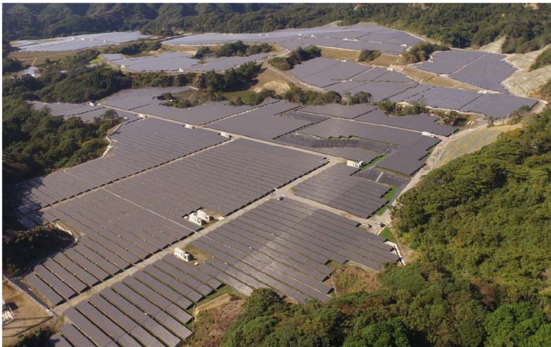
鴨川みらいソーラー太陽光発電所(写真奥)及び鴨川ソーラー発電所(写真手前)
